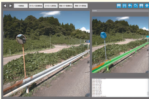
図2 道路施設の腐食検出
