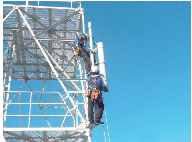
写真4 鉄塔模擬アンテナ取付等研修
