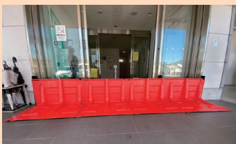
防水板（ボックスウォール）設置
