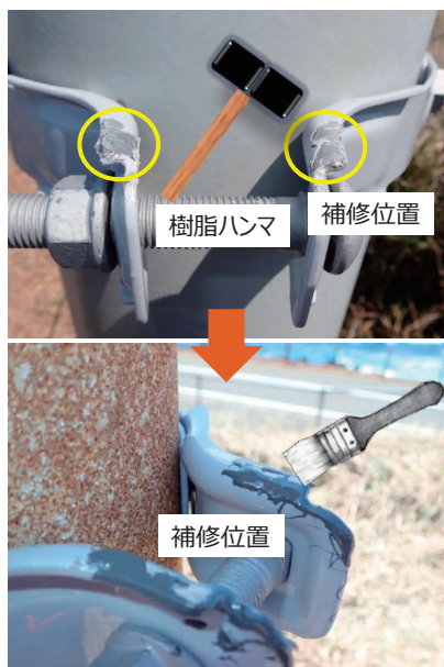
図6 バンド補修方法
