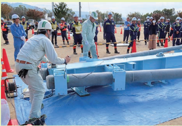
写真13 電柱の折り曲げ
