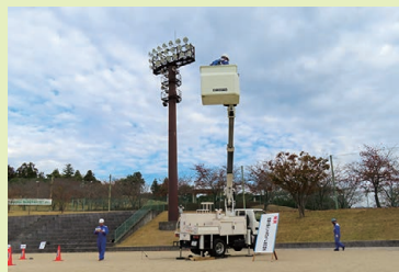
写真17 バケット車の傾き
