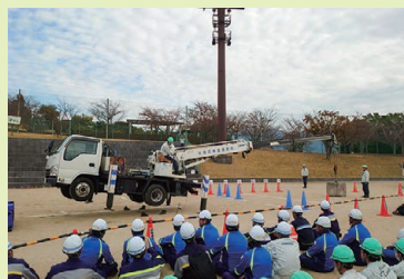
写真16 穴建車の傾き
