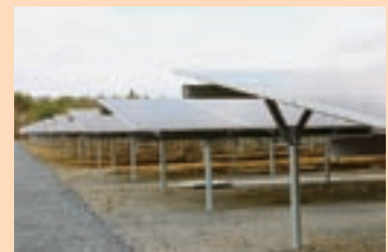
写真12 太陽光発電「施工例」
