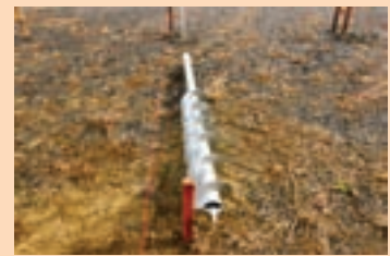
写真11 太陽光発電「スパイラル型杭」
