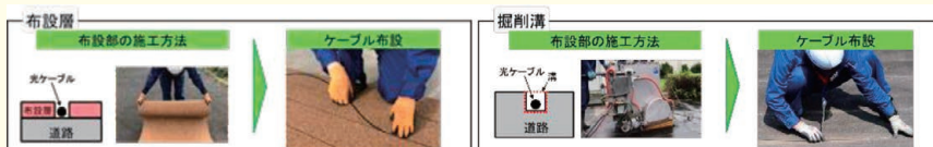
図1 路上に設けた新しい布設方法
